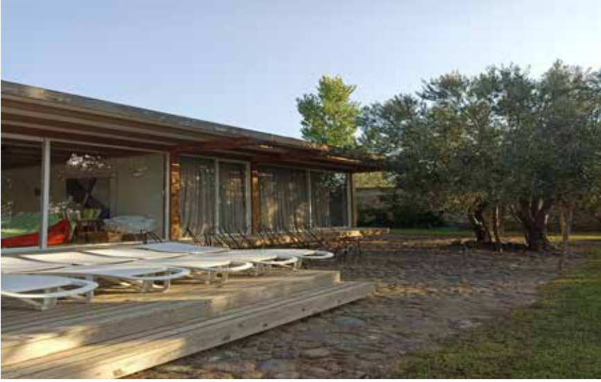
ŞEVKİ PEKİN EVİ ŞEVKİ PEKİN HOUSE
