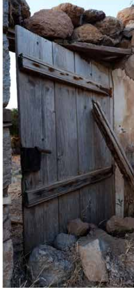
Yapıda yer alan ahşap kapı
