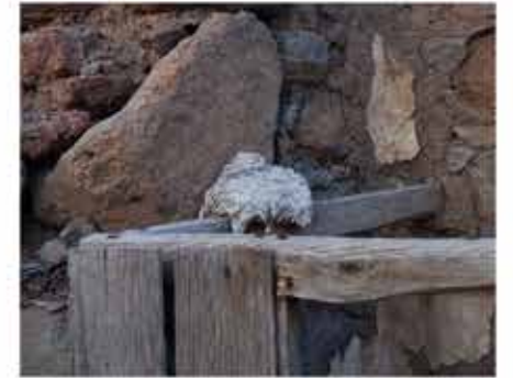
Sabit mobilya (yükklük) duvar bağlantısı
