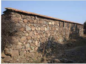
F 2: Arka duvar görünüşü.
