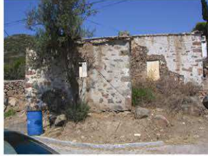
F 2: Köy Odası sağ yan görünüşü.
