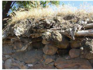
F 6: Çatı Örtüsü
