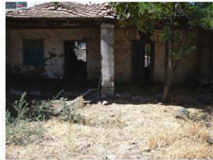
F 3: Yapının arka görünüşü.
