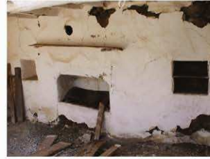
F 4: Konut içersinden görünüşü.
