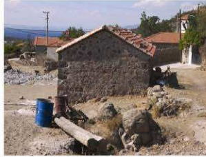
F 2: Köy Odası sağ yan görünüşü.
