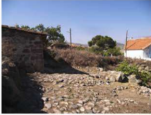
F 1: Ahır bahçe girişinden yaklaşım
