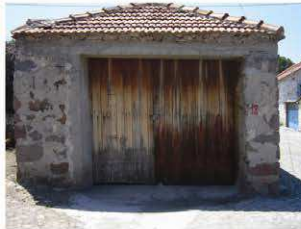
F 6: Garaj kuzey cephesi.
