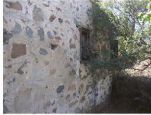
F 2: Ahır sağ yan görünüşü.
