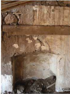
F1: Yapı içindeki baceylık.
