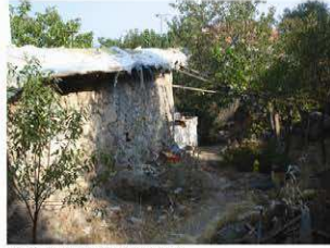
F 1: Yapının arka görünüşü.
