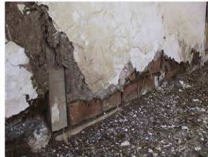
F 6: Duvar detayı.
