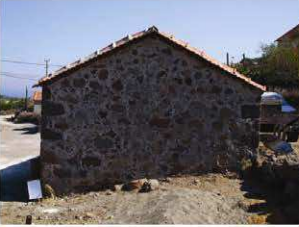
F 5: Ahır sağ yan görünüşü.
